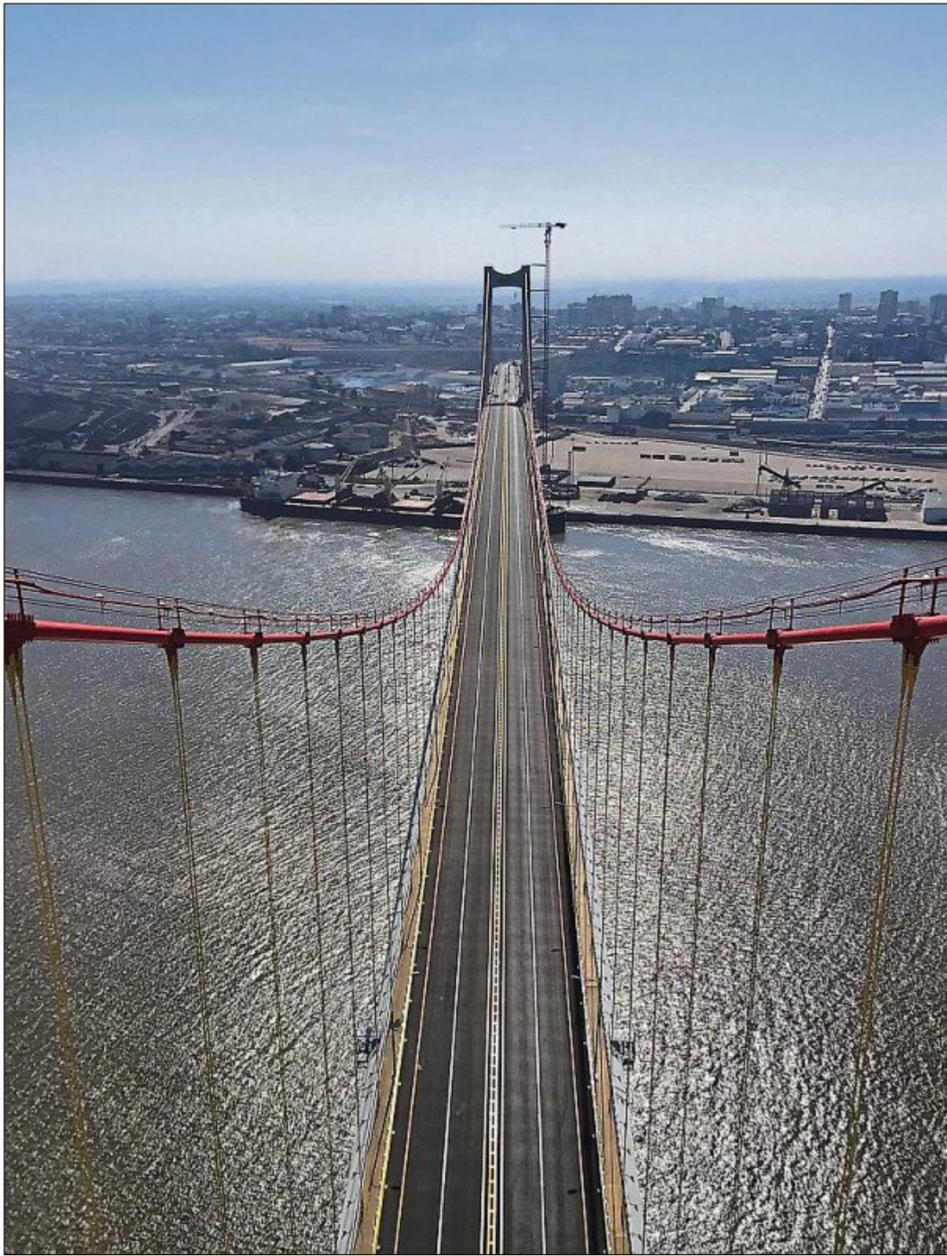
Für die Hauptbrücke wurden 57 Stahlsegmente in China produziert. FOTOS: GAUFF GMBH & CO, ENGINEERING KG, NÜRNBERG
