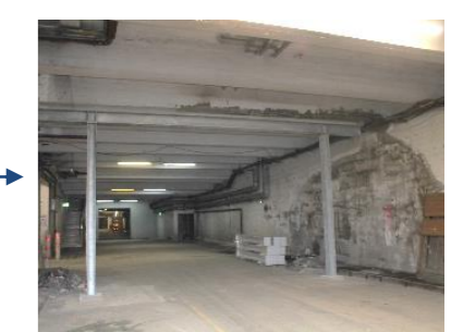
Geplante Maßnahme zur Abstützung des beschädigten Bauteils mit Bauausführung
