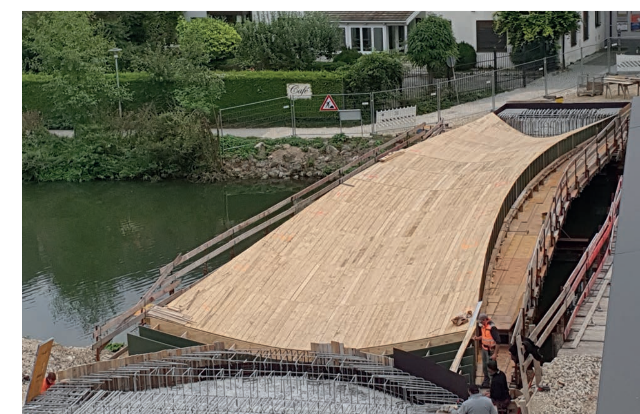
Baustellenfoto _ Bretterschalung auf Holzspannen © Bergmeister
