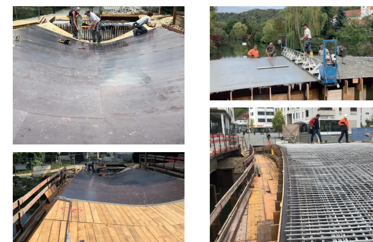
Baustellenfotos _ dreidimensional gekrümmte Schalhaut auf Bretterschalung _ Bewehrung - obere Lage Edelstahl _ Betonage mit Rüttelbalken im Profil d © J2M
