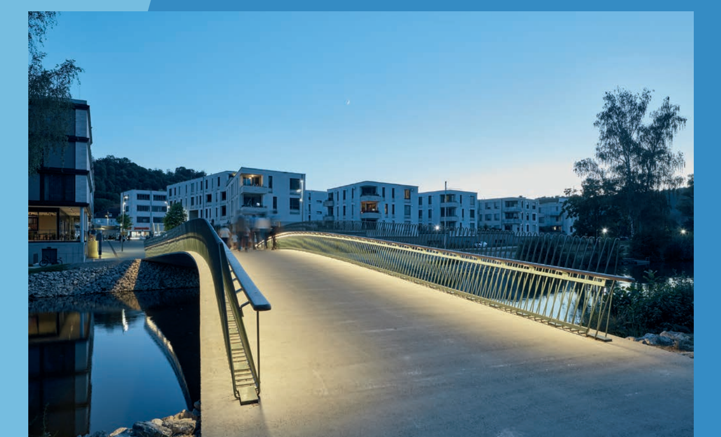
Blick von Osten, Handlaufbeleuchtung © Bruno Klonfar
